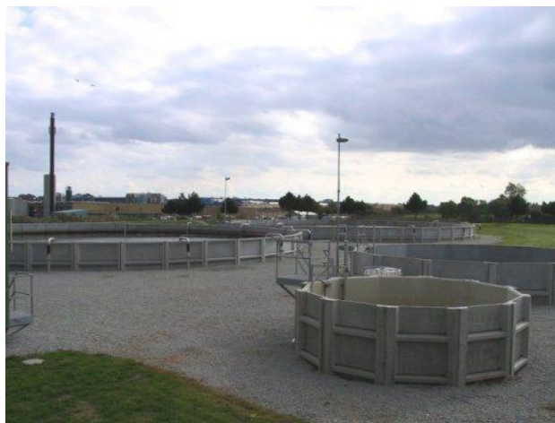
SBR tankene og de mindre slamtanke i forgrunden.
